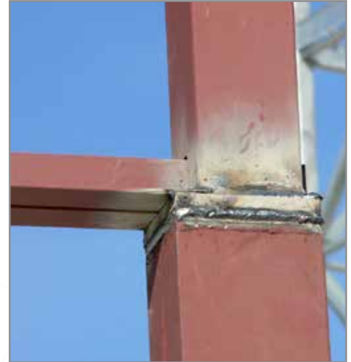
Detalle de la unión de cercha a cabeza de pilar
