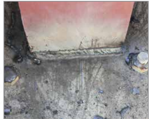
Cordón de soldadura en la unión de un pilar a placa de anclaje
