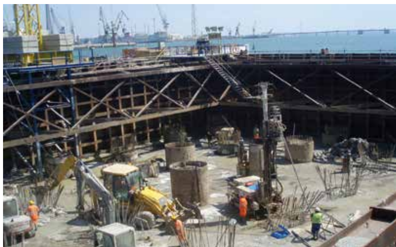
Ensayos marinos en seco por sistema de recintos estancos
