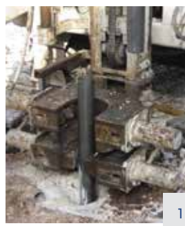
Introducción del tubo de sondeo "batería"
